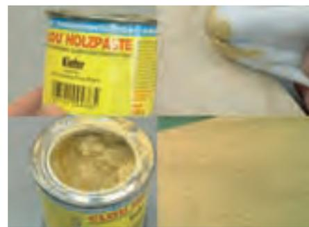
Abb. 3: Der TIY-Porenfüller: Holzpaste, verdünnt und mit dem Lappen aufgetragen
