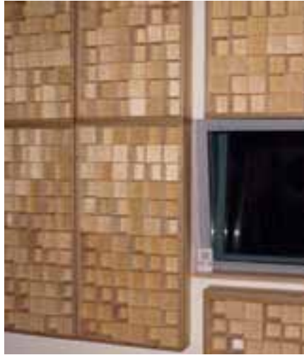
... verschieden Raumklänge. Hier seht ihr je Wechselrahmen zwei Absorber-Module ...
