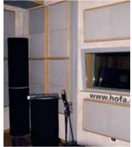
... und hier die Absorber, sowie die Basstraps zur Raumkloptimierung.
