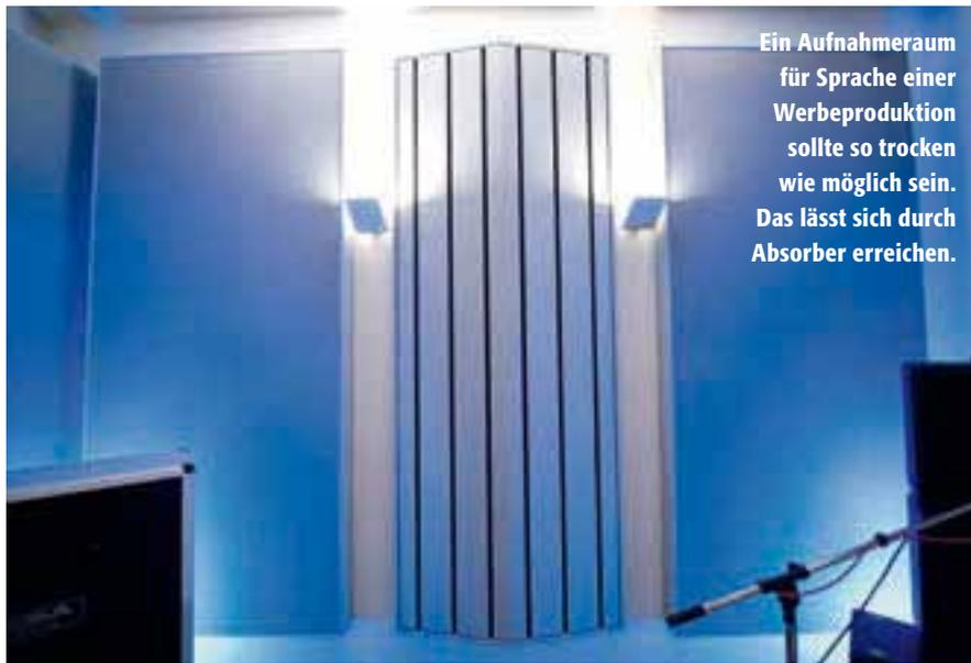
Ein Aufnahmerraum für Sprache einer Werbeproduktion sollte so trocken wie möglich sein. Das lässt sich durch Absorber erreichen.
