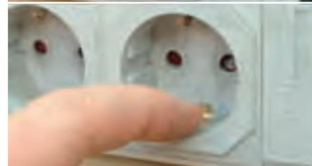
Abb. 2: Der Schutzleiterkontakt einer Steckdose dient als Massepunkt
