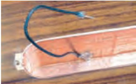
**Abb. 4:** Auch ausgekleidete Fräsungen müssen gut mit Masse verbunden werden ...
